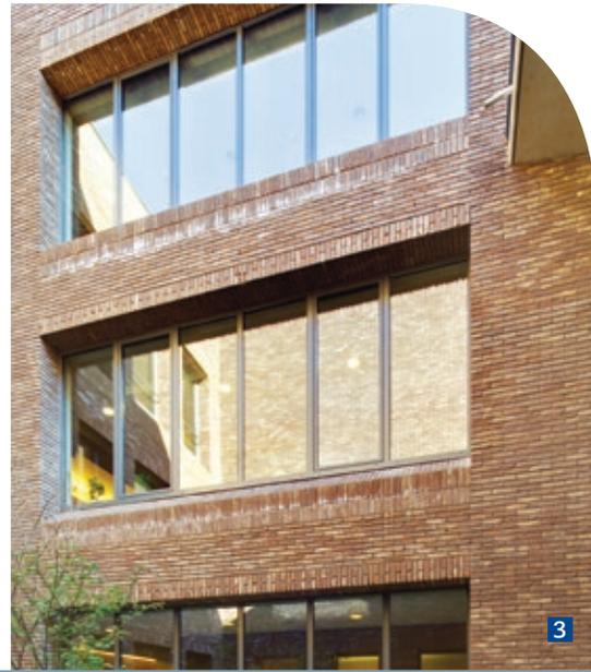
C'est un tout **nouveau système de profilés** à isolation thermique qui permet la réalisation de portes d'entrée ou fenêtres ou portes fenêtres ou fixes. Les profilés sont **entièrement fabriqués en acier recyclable, sans aucun isolant en matière synthétique**, à la différence de systèmes isolés classiques.
